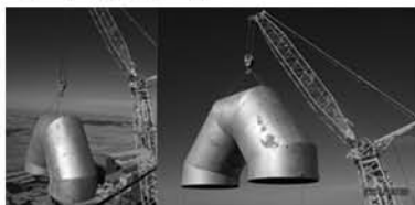
图2 BISKRA 项目分解炉至C5旋风筒风管弯头整体吊装实例
